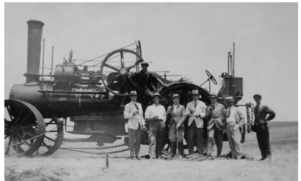
מימין: טרקטור הקיטור של פאולר למשיכת המחרשה. משמאל: המחרשה עצמה נמשכת על ידי כבל. מקור: מרכז תיעוד תל מונד.
