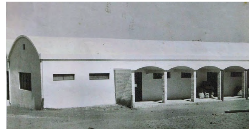
חזית המחסן. תשומת לב לקולונדת הכיפות המשלימה לגג קמרונות הבטון. מקור: מרכז תיעוד תל מונד.
